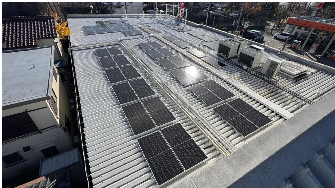
ヤマイチ小岩店では屋根上に太陽光パネルを設置し、2025年12月より発電を開始しました。このたびの自家消費型太陽光発電設備の導入により年間約16トンのCO2排出量が削減できる見込みです。
